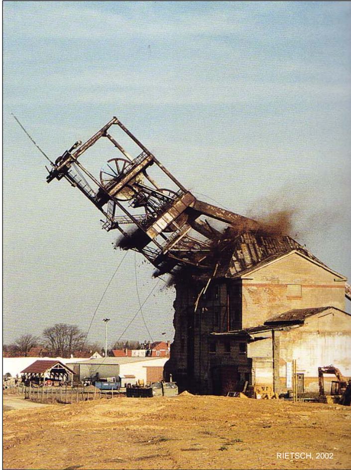
Photo 28: Abattage du chevalement Ensisheim I en mars 1999 (Ensisheim). Plus de 16 millions de tonnes de minerai ont été extraites jusqu'en 1961, date d'arrêt de son exploitation. Le puits est remblayé en 1989. Le chevalement, photographié ici, après dix longues années de décrépitude, est finalement abattu le 17 mars 1999. « Un à un, les chevalements qui faisaient la fierté du bassin sont abattus. Dans la poussière, avec un fracas de poutres broyées, des mastodontes s'effondrent. Pour les anciens, qui viennent parfois assister à cet ultime spectacle, c'est un moment de forte émotion. Ils sont tristes, mais regrettent-ils la mort de cet univers si dur et si contraignant? Les sentiments sont partagés. » (RIETSCH, 2002).
