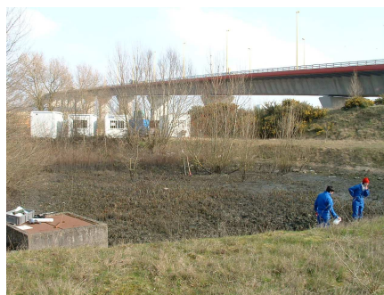
(b) Vue du bassin depuis la route d'accès
