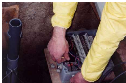
FIGURE 3.5 – Mise en place de la sonde.
