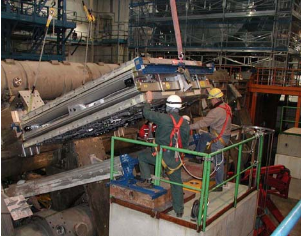
FIG. 2.28 – Insertion d'une chambre à muons de type BMF (Barrel Middle radius Feet) de la partie tonneau entre les aimants toroïdaux.
