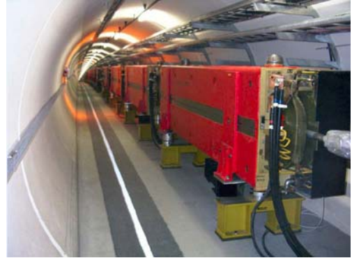
FIG. 1.7 – Vue d'une des 2 lignes d'injection : TI 2 qui amènera les protons du SPS vers le secteur 2 du LHC.
