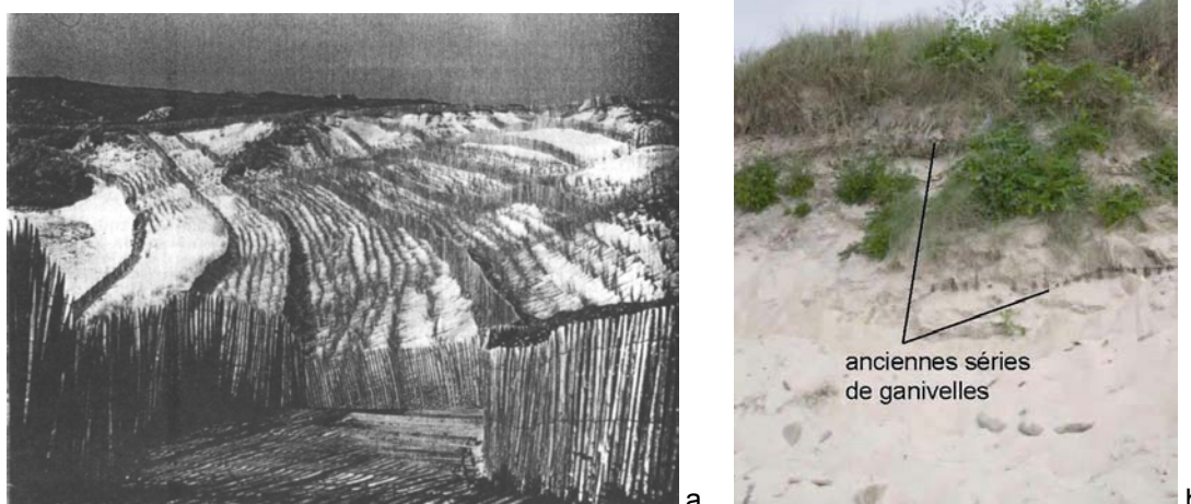
Illustration 160. (a) Les dunes des Blancs Sablons en 1982 lors des travaux de restauration (Guilcher et Hallegouet, 1991), (b) affleurement en mai 2005 des anciennes lignes de ganivelles au niveau du front dunaire sur le secteur 2.
