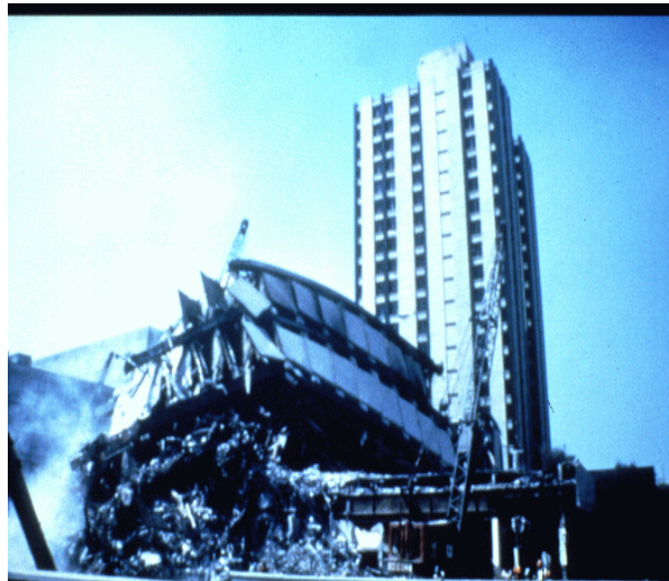
FIG. 1.1 – Mexico, tremblement de terre de Michacan, le 19 Septembre 1985. Effondrement total d'un immeuble de 21 étages.
