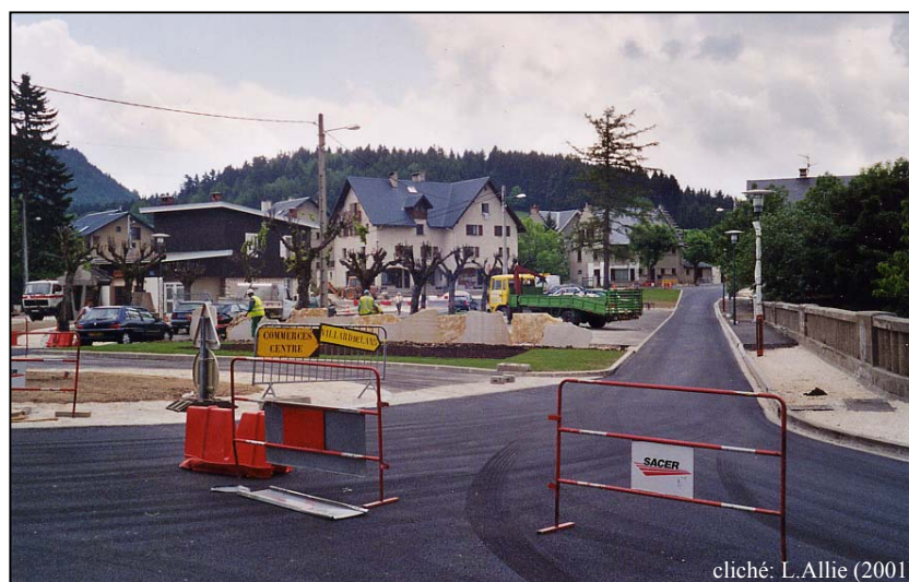
Photo 2: L'amélioration de la route à Saint-Nizier-du-Moucherotte
