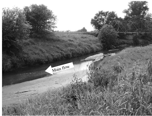
FIG. 8.1: Photo du site de mesure à Old Man's Creek le 17 Août 2005. Le pont abritant la station de jaugeage USGS est visible en arrière plan.
