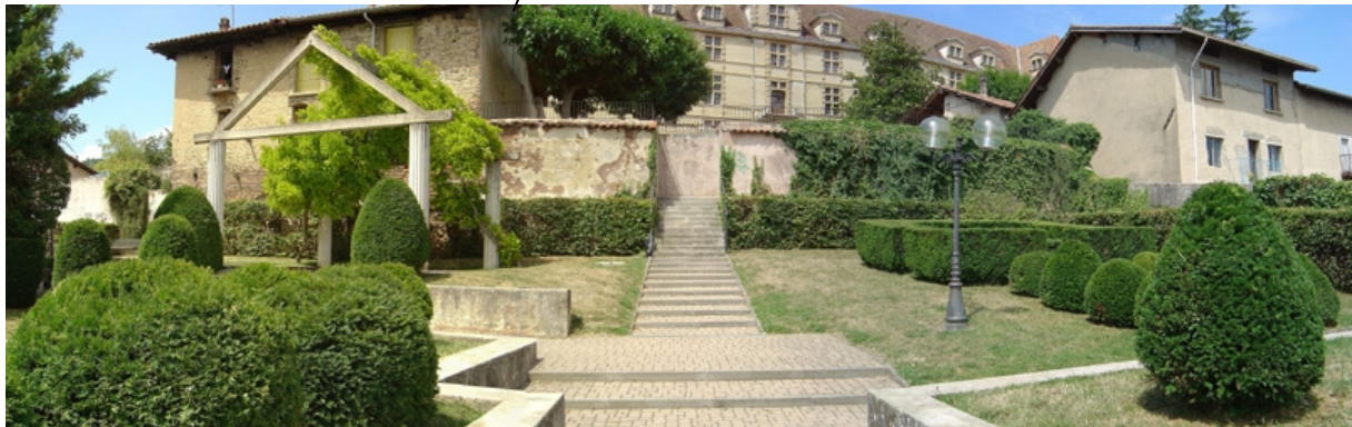
Photographie 38 : La Côte Saint-André, les Terrasses du Douaire, création de cheminements piétons, espaces verts, placettes, terrasses, bassins, éclairage...
