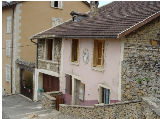
Photographie 27 : Murets de pierre sèche et décors architecturaux à Crémieu.
