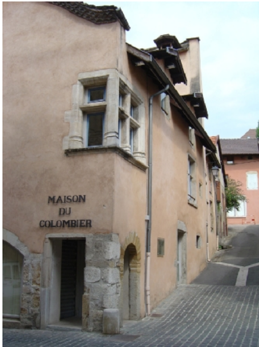
Photographie 26 : Crémieu, maison du Colombier : demeure urbaine devenue lieu d'exposition ; façade enduite à la chaux, fenêtre à meneaux en angle du 15 e siècle. La bordure de la toiture est en lauzes mais le reste que l'on ne voit pas d'en bas est en tuile : « on a de la tuile et simplement une bordure de lauze qui permet de se souvenir que c'était une toiture en lauzes et de garder l'impression que c'était une toiture en lauzes depuis le bas. » (Entretien avec Estelle Couchouron, op. cit. ).
