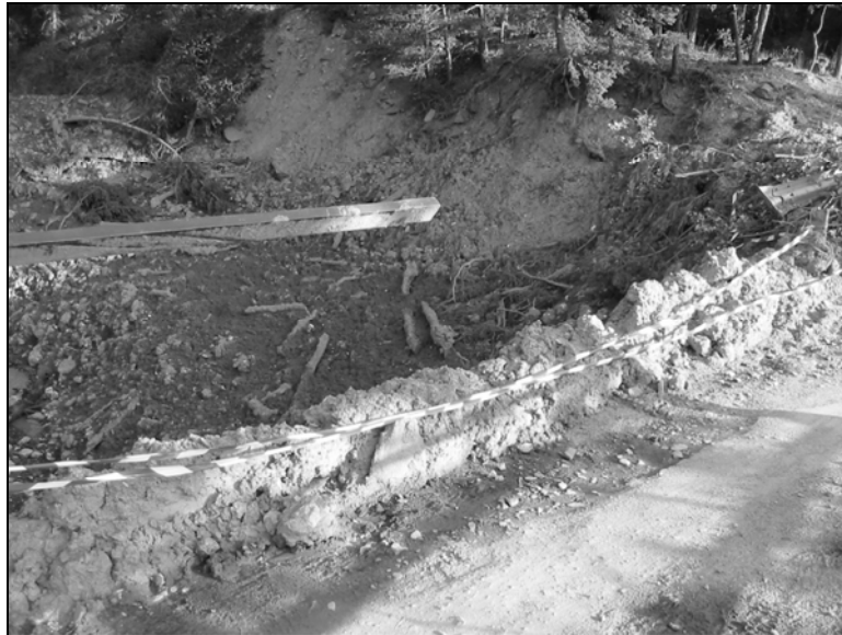
Figure 4.36 : Vue vers l'amont sur le pont du Châtelaret (1278 m).
