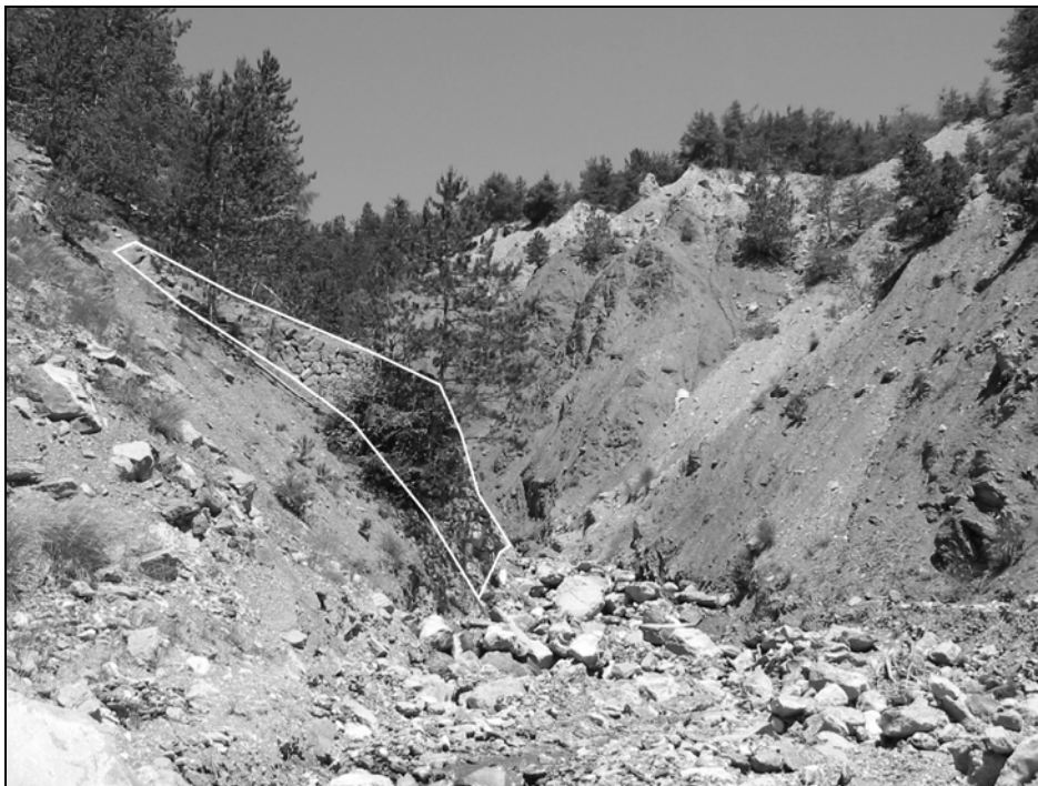
Figure 4.18 : Vue sur le chenal torrentiel de Faucon en aval du seuil 15b (septembre 1998).
