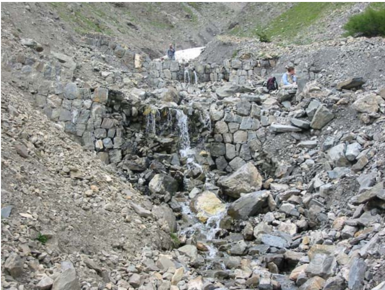
Id 99 n° 60+11 RTM n°71 Alt : 2192.1 Juillet 2004 Photo 105 Id 100 n° 60+12 RTM n°72 Alt : 2194.8 Juillet 2004 Photo 105
