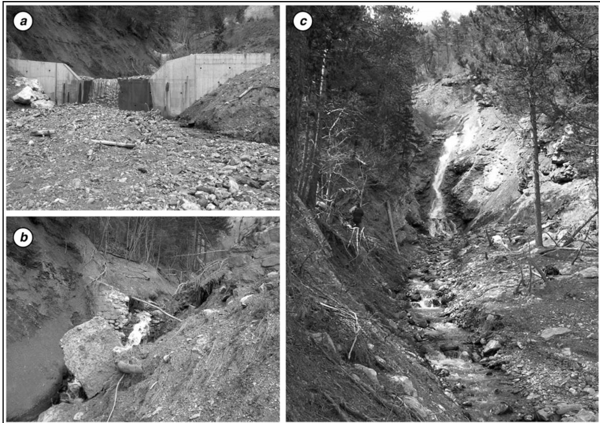
Figure 3.14 : Prise de vue (a) d'un seuil bétonné (N°26), (b) d'un seuil maçonné (N°29) et (c) d'un seuil naturel sur le torrent du Bourget.
