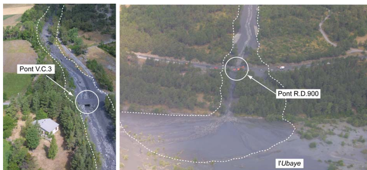
Figure 3.26 : Dégâts et débordements sur le cône de déjection du torrent du Bourget (Photographies prises le 6 août 2003 par M. Peyron (Services RTM, Barcelonnette)).
