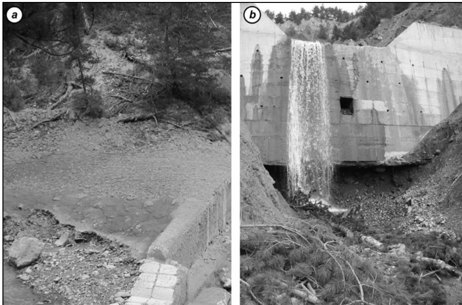
Figure 4.39 : Morphologie de la lave torrentielle du 5 août 2003 au torrent de Faucon au droit des seuils 6 et 15.
