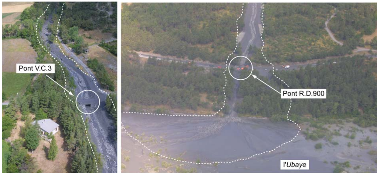
Figure 3.26 : Dégâts et débordements sur le cône de déjection du torrent du Bourget (Photographies prises le 6 août 2003 par M. Peyron (Services RTM, Barcelonnette)).
