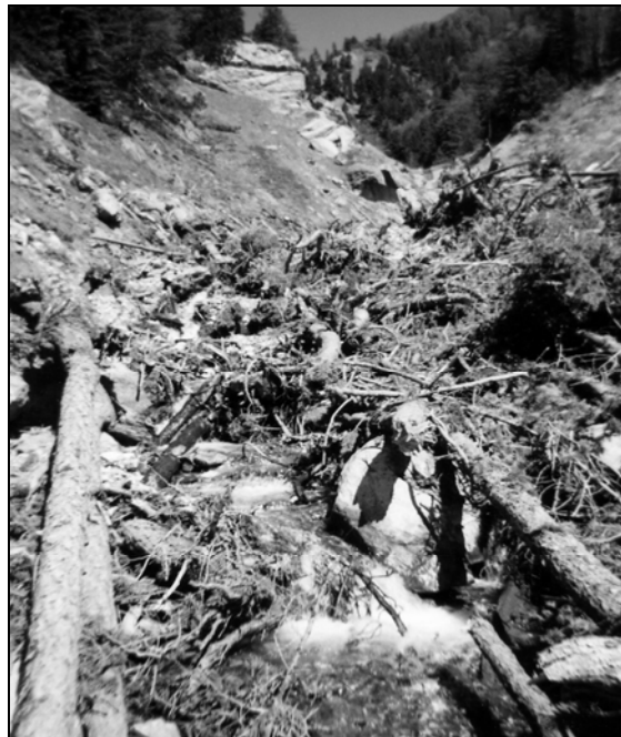
Figure 4.20 : vue sur un embâcle en amont du seuil 22 (septembre 98).
