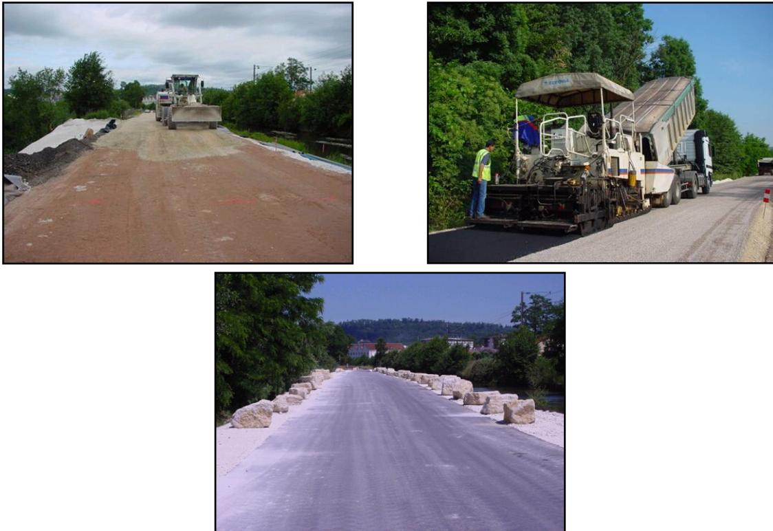
Photo 1-4: les différentes étapes de la construction de la route de démonstration du procédé Revasol® à Dombasles.
