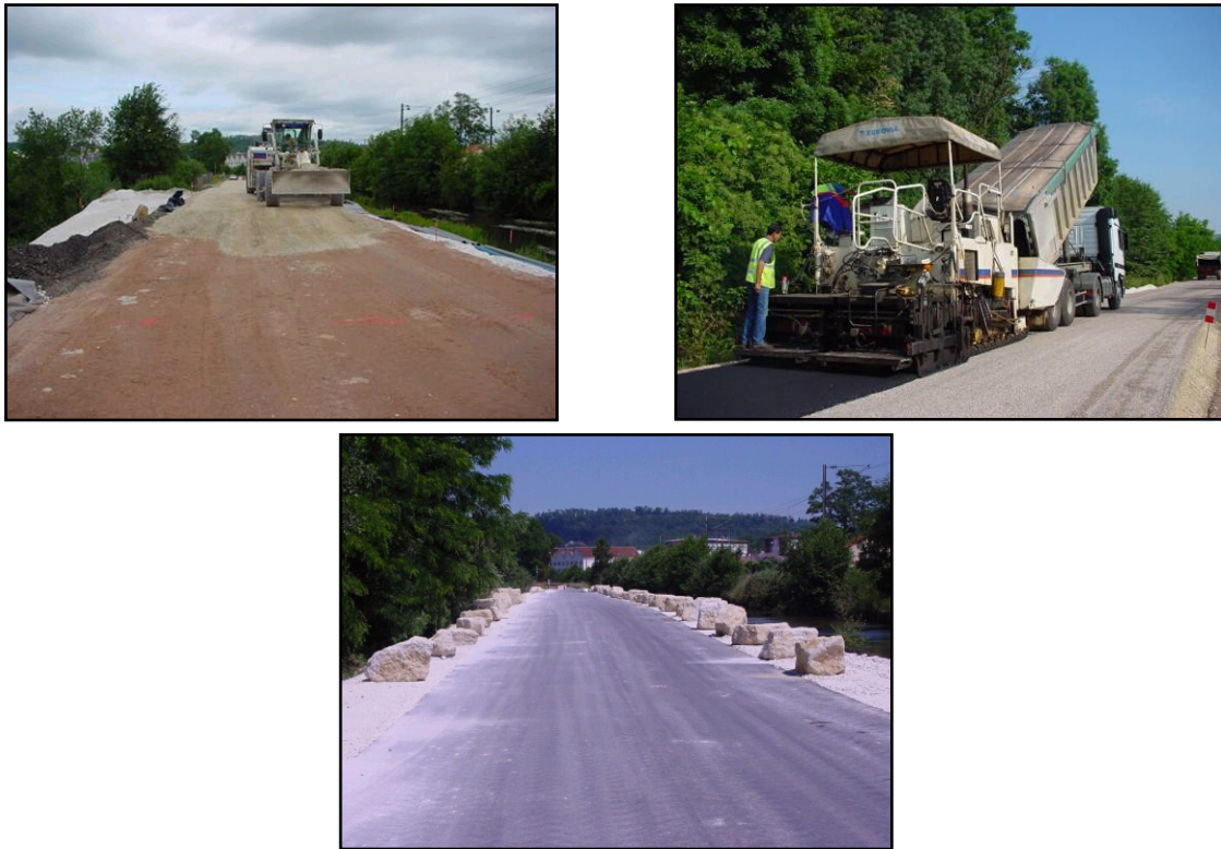
Photo 1-4: les différentes étapes de la construction de la route de démonstration du procédé Revasol® à Dombasles.
