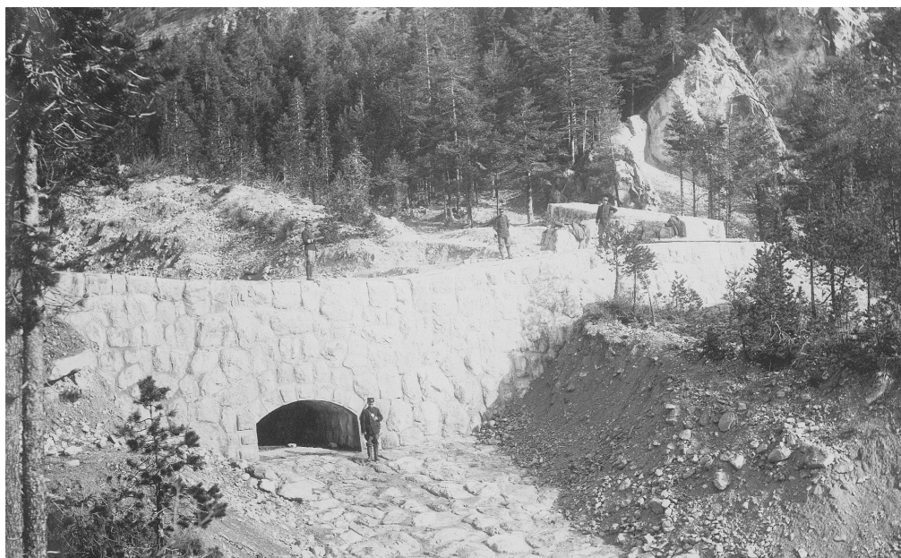
Photo. 15 : Torrent de Malefosse, le premier barrage en maçonnerie construit en 1907 (photographie de 1909, archives RTM 05)
