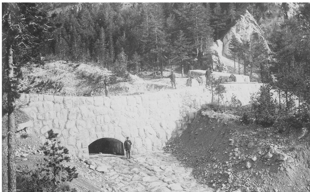
Photo. 15 : Torrent de Malefosse, le premier barrage en maçonnerie construit en 1907 (photographie de 1909, archives RTM 05)
