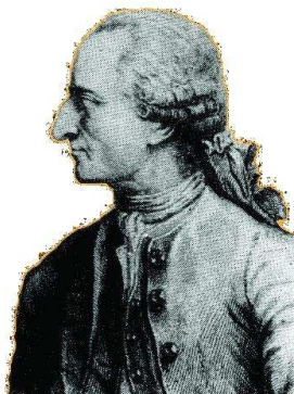
FIG. 1.6 : Ingénieur et mathématicien français, Antoine de Chézy a laissé de nombreux mémoires manuscrits. On lui doit surtout la construction de quelques ouvrages importants, comme les ponts de Neuilly, de Mantes et du Tréport.
