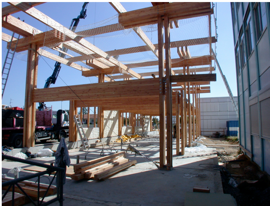
Figure 4 : Chantier du collège de Blénod-Lès-Pont-À-Mousson
