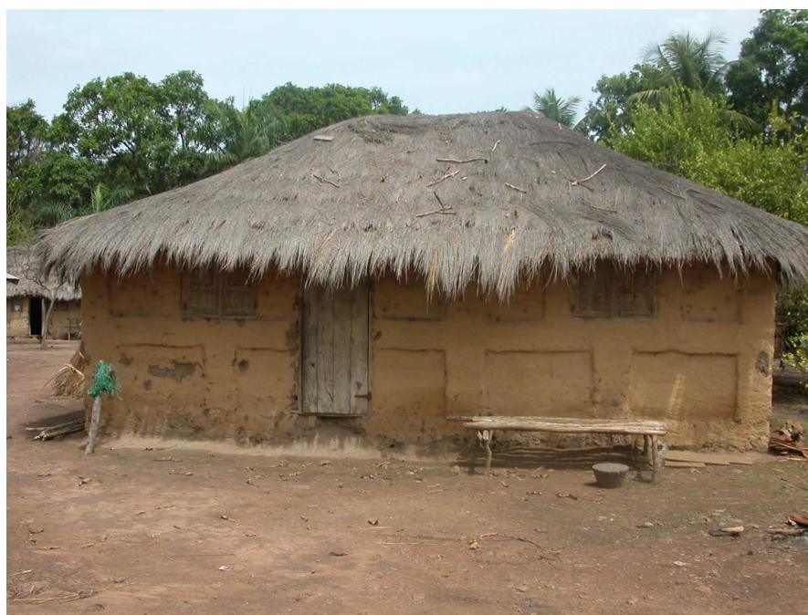
Habitat : maison principale, toit de chaume (Kanfarandé)
