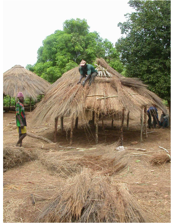
Habitat : construction d'une cuisine (Kanfarandé)
