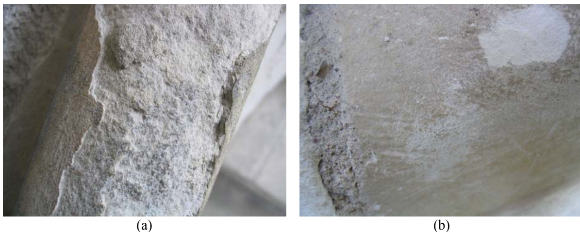
Figure I.3 : patines observées sur une main courante en tuffeau (cloître de la Psalette – Tours). (I.3.a : patine sur une pierre ancienne ; I.3.b : patine sur une pierre posée en 1998)
