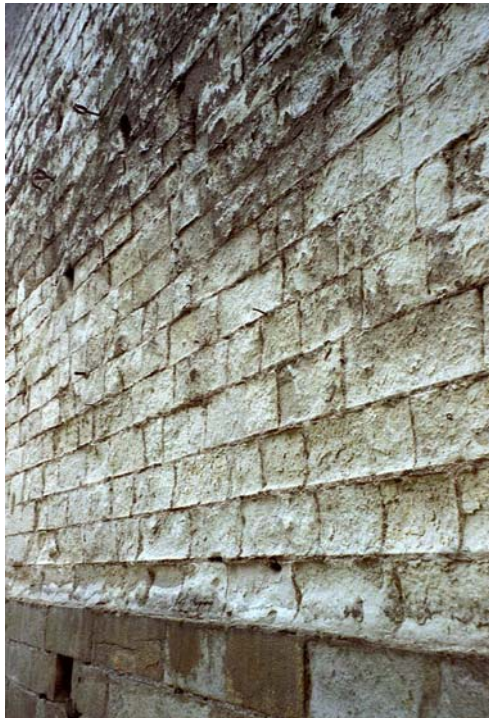
Figure I.19 (ci-dessus): désagrégation sableuse sur un mur en pierre de Sébastopol (Mello)
