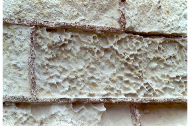
Figure I.21 (ci-dessus) : alvéolisation sur un mur en tuffeau (château des ducs de Bretagne – Nantes)
