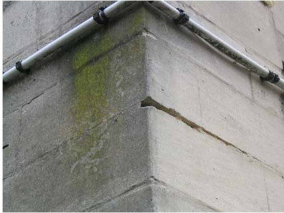
Figure I.23 (ci-dessus) : développement d'algues vertes sur un mur en pierre de Sébastopol exposé aux pluies (Cramoisy)
