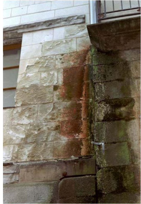
Figure I.23 (ci-dessus) : développement d'algues vertes sur un mur en pierre de Sébastopol exposé aux pluies (Cramoisy)
