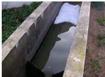
Effluents de S3 – canal de sortie
