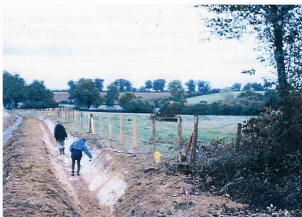
Prospection dans les fossés récemment creusés de la D. 22 (Buxière-les-Mines, La Loeuf (Allier))
