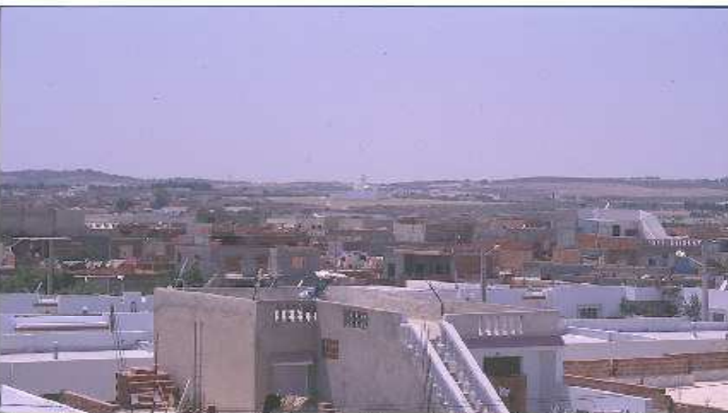
Photo 9 - Escalier extérieur, façades enduites et balustrades à Sidi Hacine (juin 2000)
