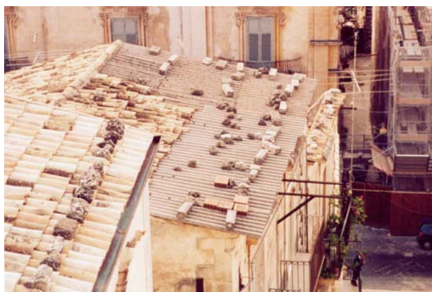
Cliché 1.13. Des réparations incertaines dans le centre de Noto.
