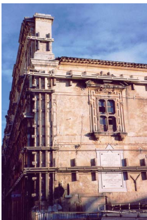
Cliché 2.3. Consolidation du palais des Jésuites à Noto.
