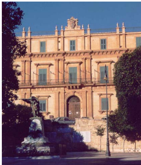
Cliché 5.6. La façade restaurée du palais Landolina à Noto.
