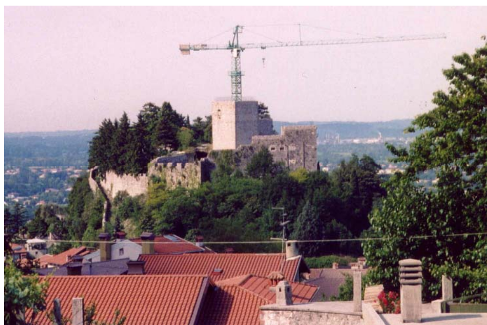
Cliché 5.19. La reconstruction du château de Gémone.
