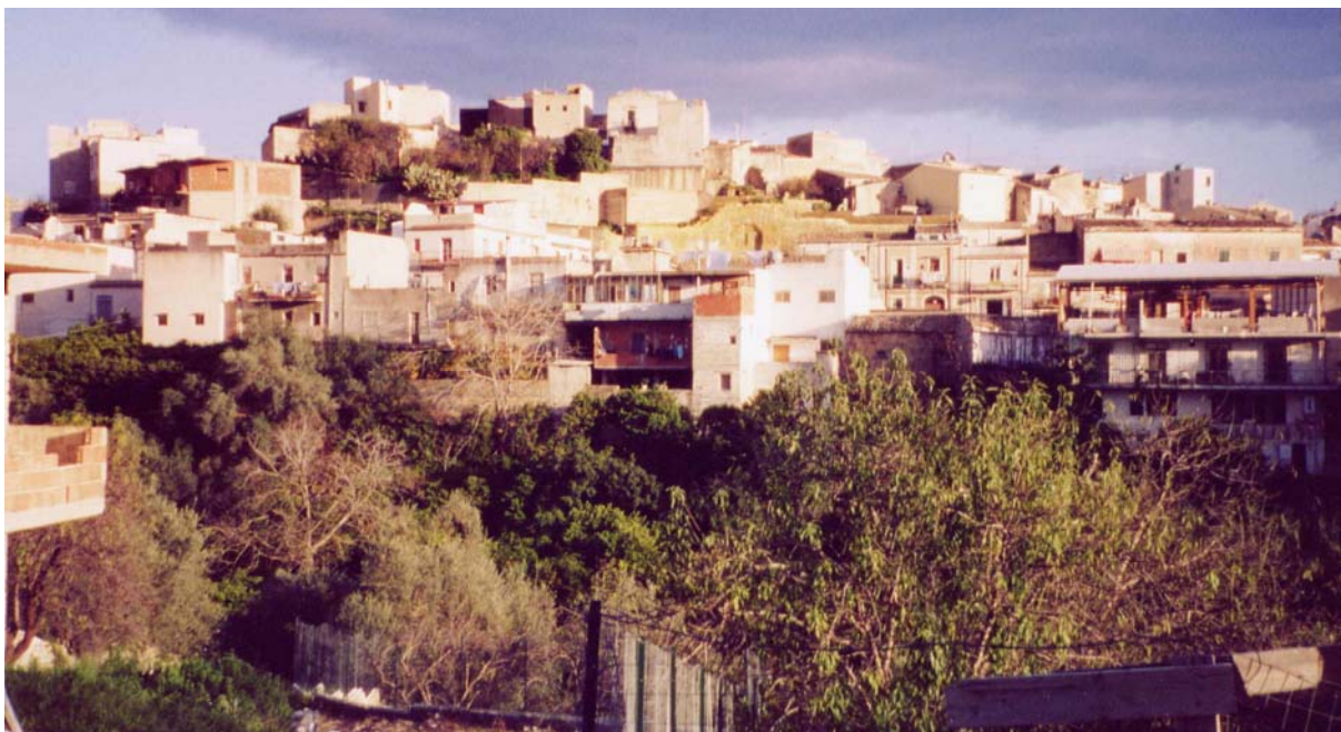
Cliché 1.8. Constructions illégales récentes aux abords de Noto (Noto ouest).
