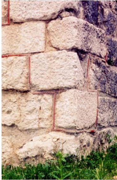
Cliché 5.4. Le pied du campanile de la cathédrale de Gémone. Conformément à la théorie de la restauration, une limite discrète distingue la partie ancienne, non détruite, de la partie reconstruite.
