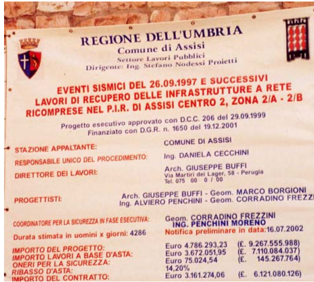
Cliché 5.8. Panneau indiquant un chantier de travaux sur les réseaux de fils et conduits à Assise.
