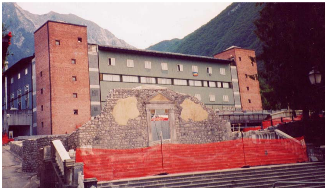
Cliché 5.10. Les travaux de la place Simonetti à Gémone. Au premier plan, les ruines de l'église Sainte Marie des Anges, en cours d'aménagement. Au fond, les nouveaux bâtiments de l'université (mai 2003).
