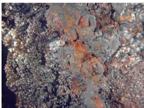
zone 2, t1 (6 heures de déchloruration)
