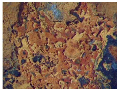
Photo G8 : détail d'un type de produit de corrosion sur le lingot en fer (L1) ; identifié type (a) grossissement : 5,5×
