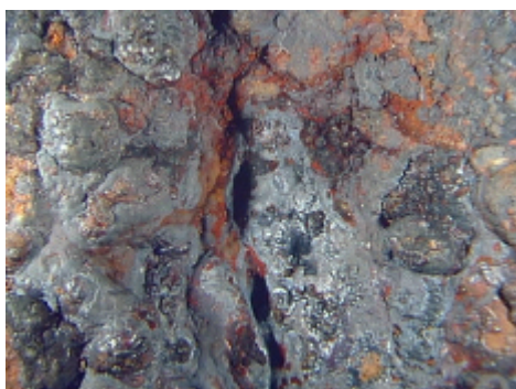
zone 3,t1 (6 heures de déchloruration)
