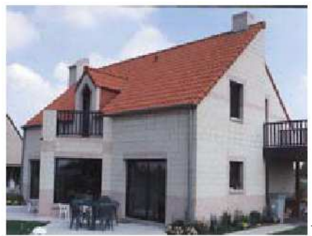
Figure 1.2 – Une application courante des blocs : la construction de murs
