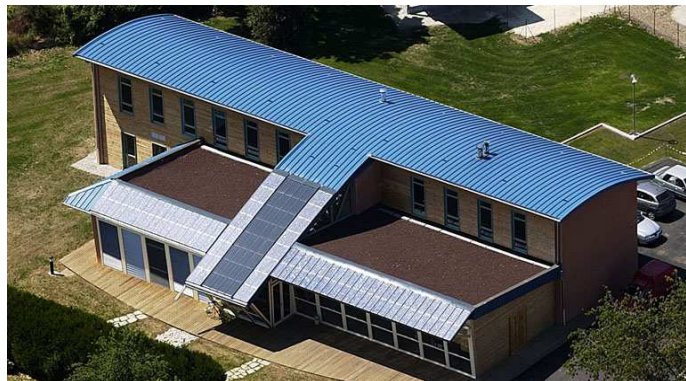
Figure 4. 6 :Vue générale (façade Sud) de la maison des énergies (WURTZ et al., 2005).
