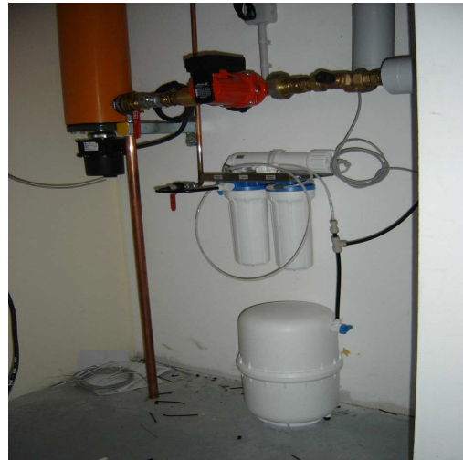
Figure 4. 14 : L'humidificateur direct placé en gaine avec l'osmoseur et son ballon tampon.
