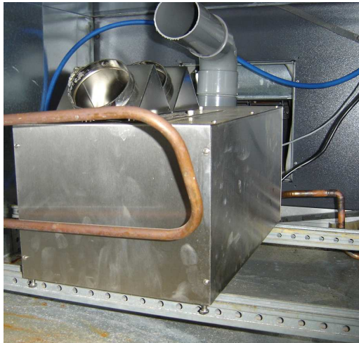
Figure 4. 14 : L'humidificateur direct placé en gaine avec l'osmoseur et son ballon tampon.
