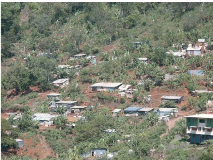
Photo 22 - Extension du bâti par des wadjen sur les pentes de Kavani (Mamoudzou - Mayotte)
