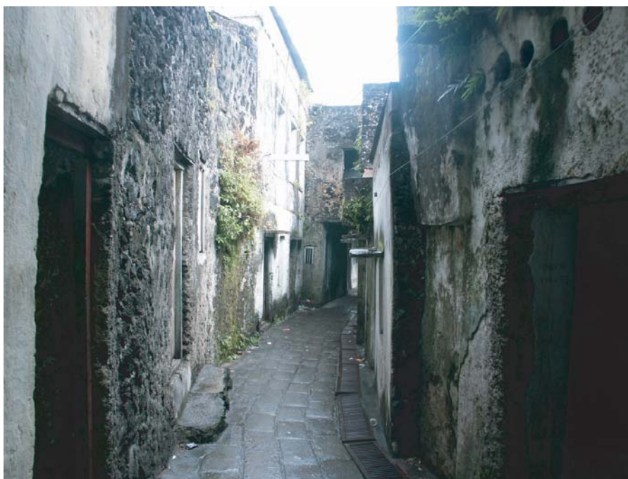
Photo 30 - Un exemple de réalisation du CASM : le pavage et l'installation de caniveaux dans le quartier de Mtsangani (Moroni - Grande-Comore)
