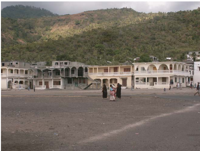
Photo 20 - Cases à étage en périphérie du centre ancien à Fumbuni (Grande-Comore)
