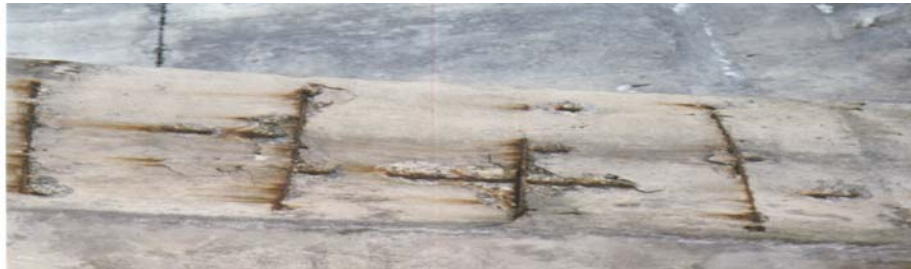
(b) Corrosion des armatures
