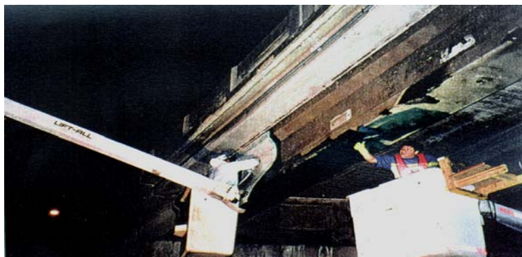
Figure Erreur ! Il n'y a pas de texte répondant à ce style dans ce document.-24. Mise en œuvre sur un pont (procédé Replark , 1996)
