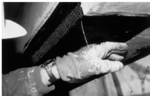
Figure Erreur ! Il n'y a pas de texte répondant à ce style dans ce document.-26 : Renforcement par TFC de surfaces non planes
