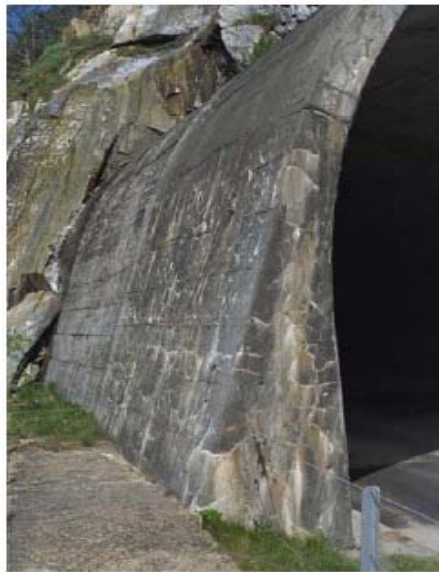
Figure Erreur ! Il n'y a pas de texte répondant à ce style dans ce document. -2 : Entrée d'un tunnel.
