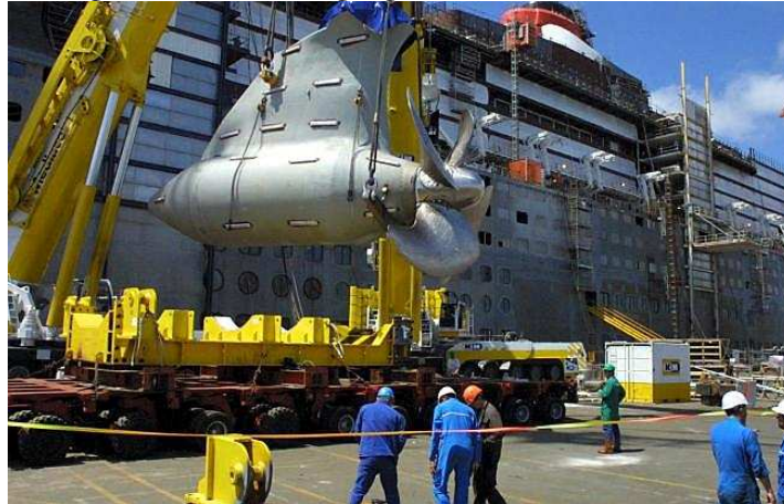
Figure 1.2 : Installation d'un POD (Queen Mary II- http://www.worldshipny.com )
