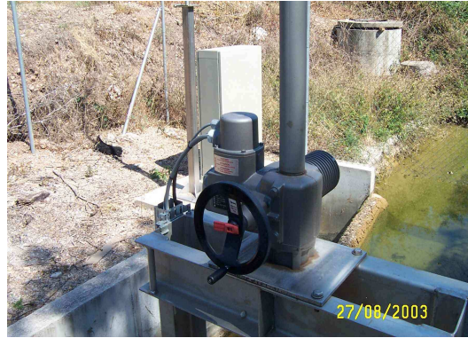
FIG. 3.5 – Actionneur de la vanne
