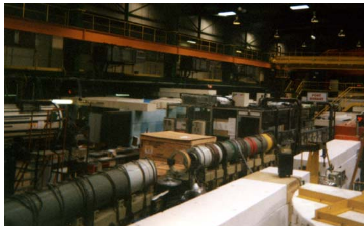
Figure 12 : Salle des spectromètres du réacteur Orphée du CEA Saclay. La ligne PACE se trouve au niveau du mur bleu (au fond).
