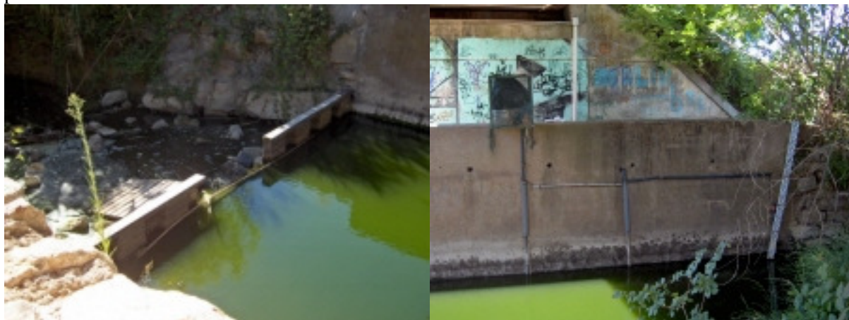
Figure B-I.c : Seuil artificiel de la station V.
