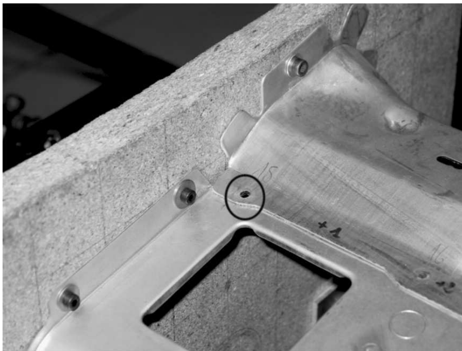
FIG. 8.13 – Vue du tablier, point de soudure 15 supprimé
