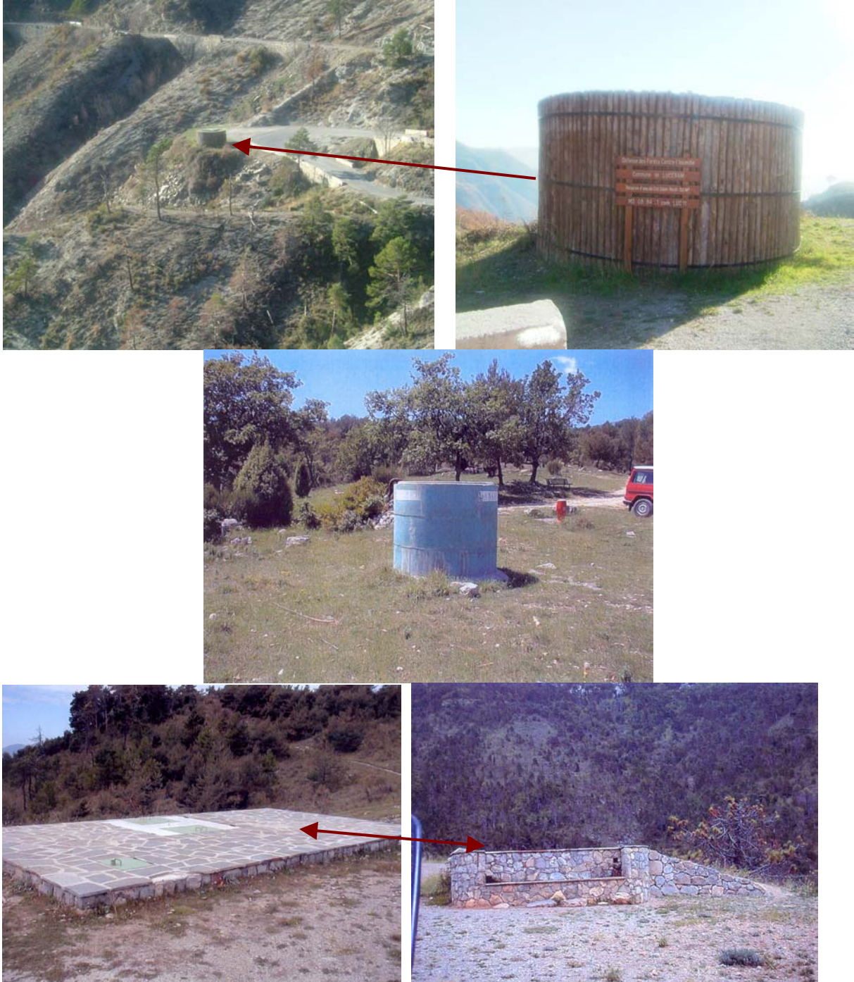
Photos 11 : Différents types de points d'eau mis en place dans le bassin versant du Paillon (photos 1 et 2 : citerne en bois ; photo 3 : citerne en ciment et photos 4 et 5 : bassin)
