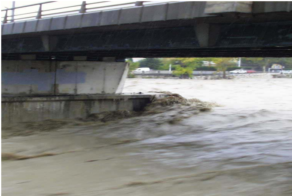
Photo 14 : Inondation, Paillon novembre 2000
