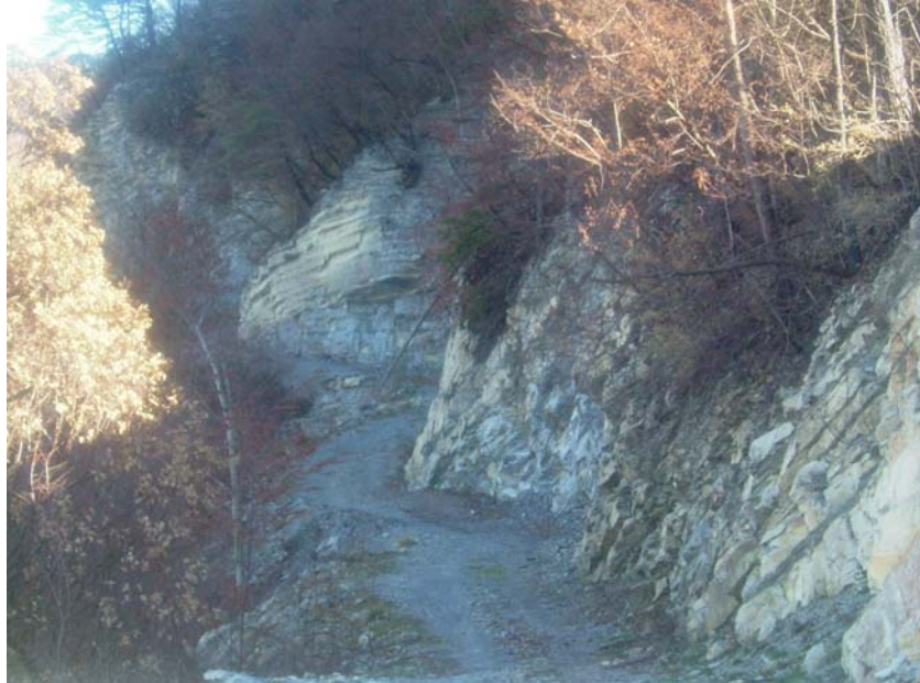
Photo 10 : Exemple d'une piste en cul de sac dans le massif du Lucéram, entamée par les pompiers lors de l'incendie du 15 juillet 2003.
