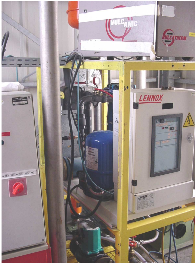
Figure D-3 : Groupe frigorifique Phétep et Chaudières CH401.
