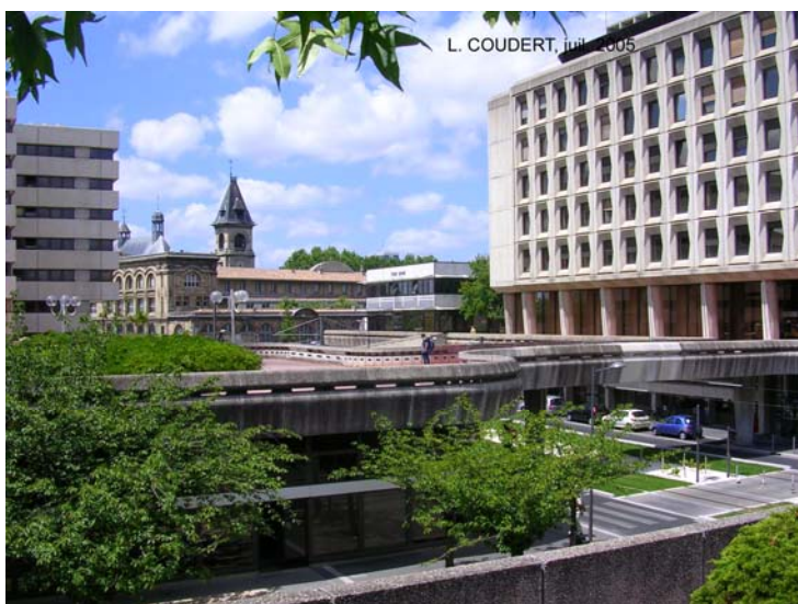
Photographie 38 – La dalle du nouveau Mériadeck et en arrière plan, l'église Saint-Bruno.
