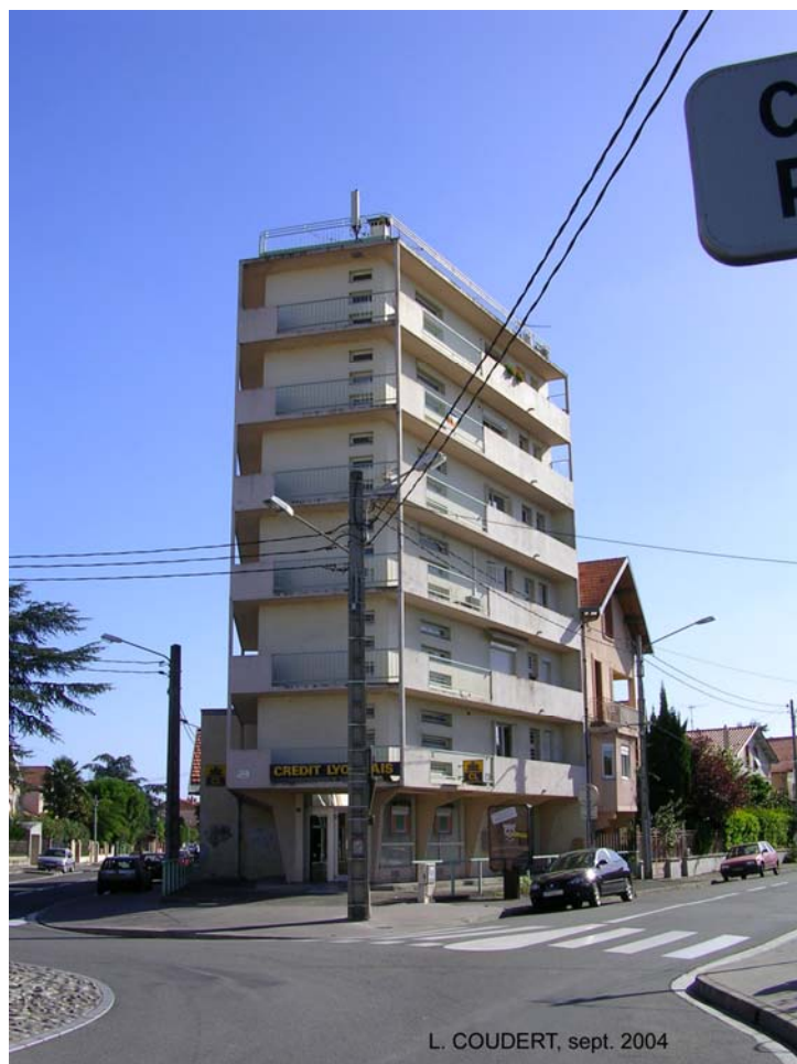
Photographie 26 – Immeuble de la place d'Italie à Toulouse.
