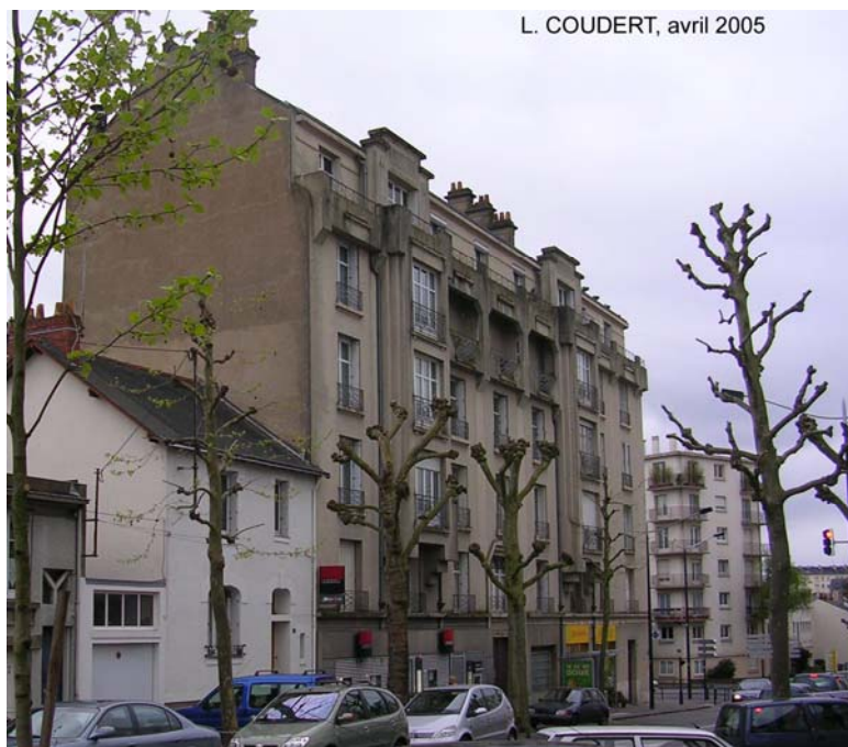
Photographie 14 – Immeuble péricentral, près du Rond-Point de Vannes à Nantes.
