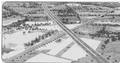
Le viaduc des Barrails
