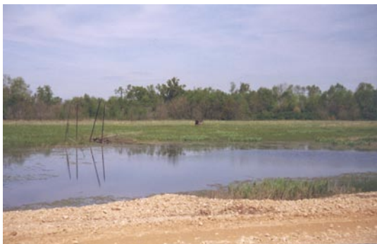
Photo n°A55 : Une «tone» au milieu du chantier autoroutier
