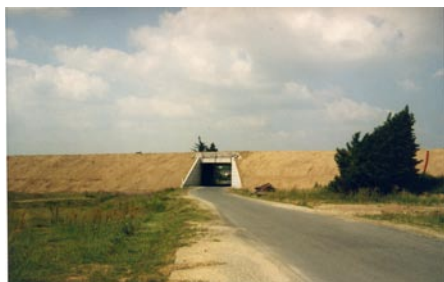
Photo n°A49 : Le remblai de l'A89 vu depuis la propriété d'un habitant
