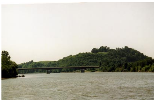
Photo n°A17 : Le viaduc du Mascaret vu depuis Libourne
