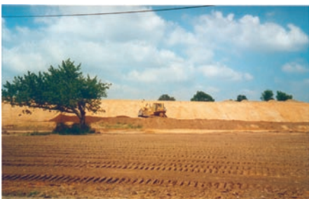
Photo n°A51 : Le remblai de l'A89 vu depuis la propriété d'un habitant
