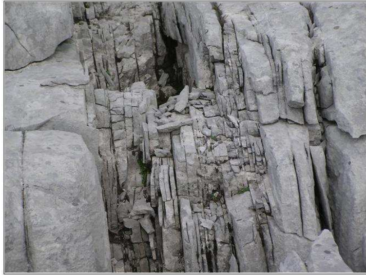
FIGURE I.2.12 – Exemple de couloir fracturé dense dans un banc calcaire épais. Photo de J.P. Petit.
