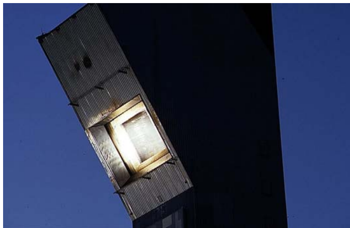
Figure 44 : cavité réceptrice de la Centrale THEMIS
