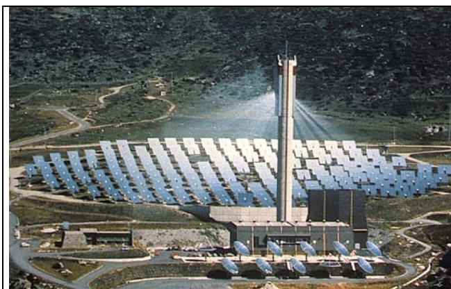
Figure 41 : Vue aérienne de la centrale THEMIS en fonctionnement
