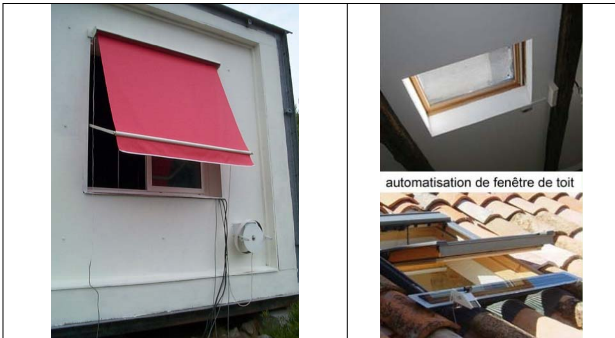
Figure 31 : Essais d'un système SOS et installation sur site réel
