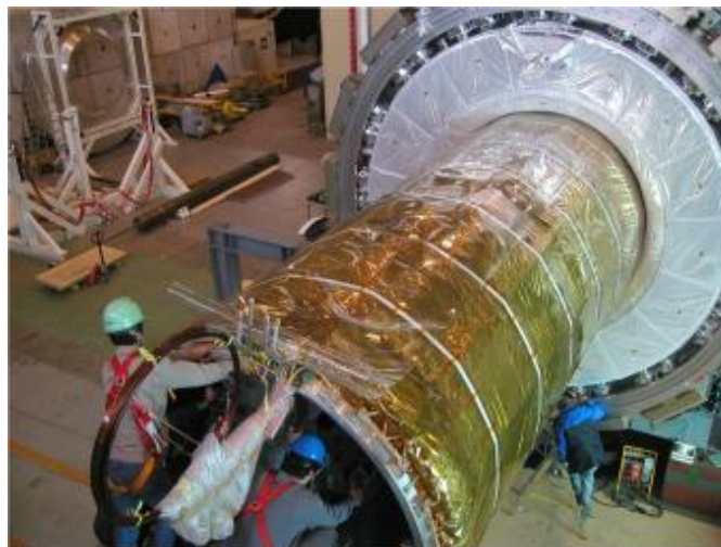
FIGURE 3.5 – Installation de l’aimant solénoïdal dans le cryostat du calorimètre électromagnétique tonneau, en février 2004.
