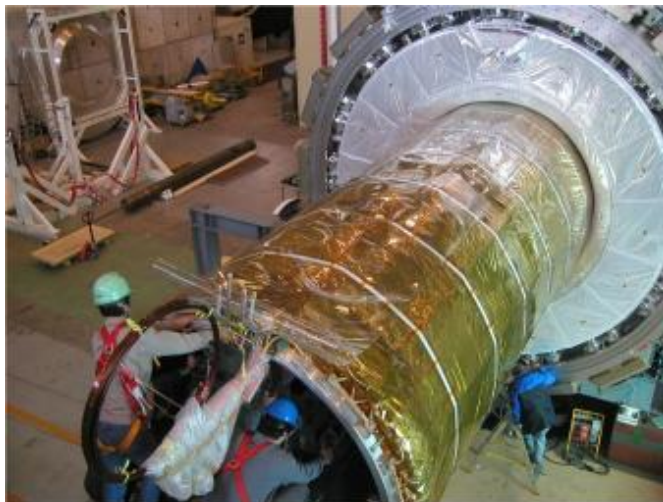
FIGURE 3.5 – Installation de l'aimant solénoïdal dans le cryostat du calorimètre électromagnétique tonneau, en février 2004.
