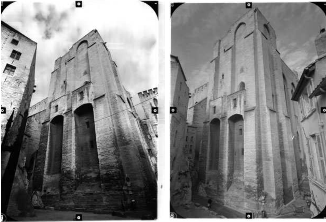
Vues extérieures Sud-est, photographies PIERRE DRAP
