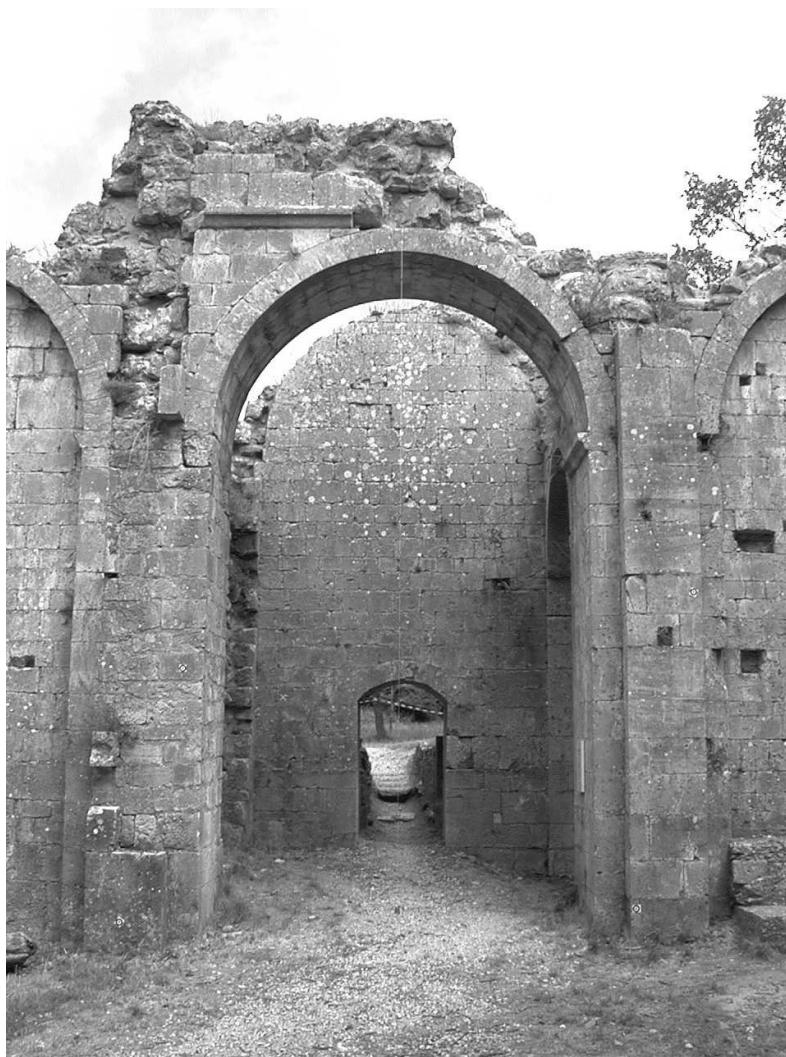
FIGURE 7.34 – Vue de l'arc dans l'axe du transept Nord
