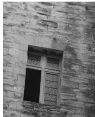
(c) Détail de la baie, face Ouest
