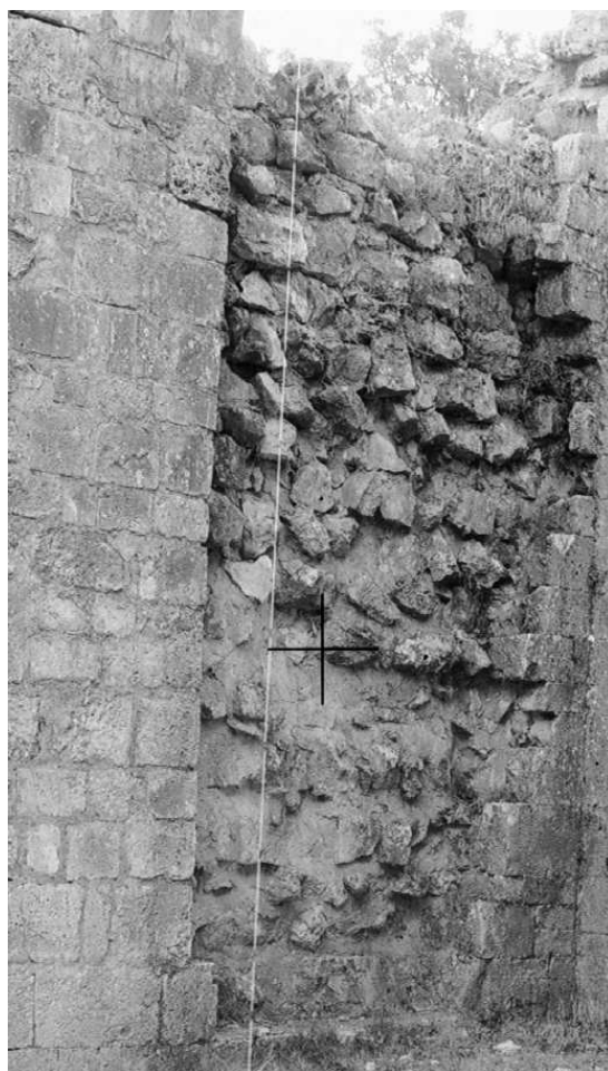
FIGURE 1.2 – Détails d'un appareil de parement en joints vifs et du blocage mis à nu — Prieuré N.D. D'Aleyrac, Drome(26)
