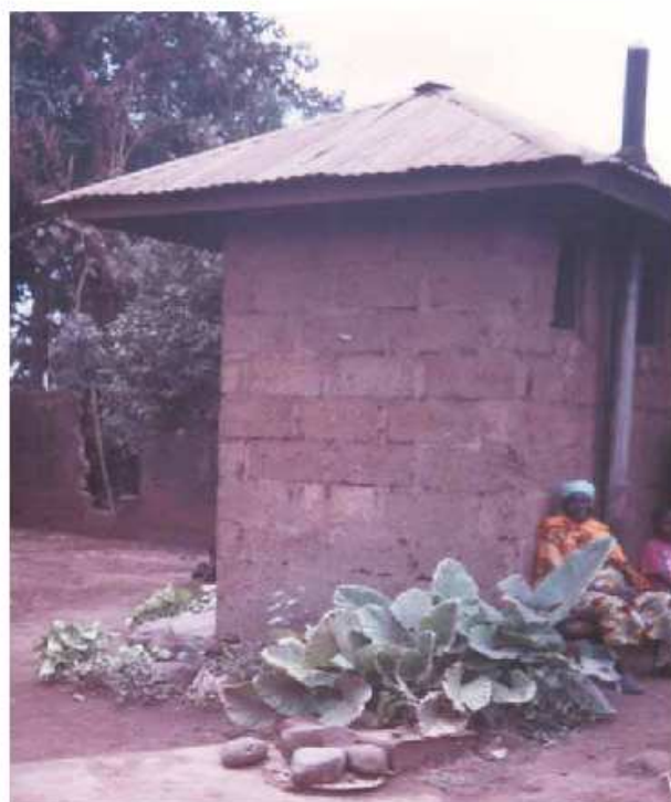
Latrines haut standing (VIP)
