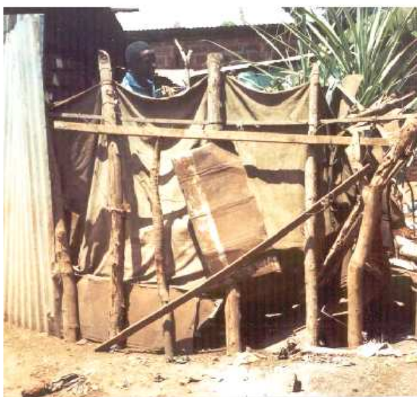
Latrines précaires non couvertes ("passport size")
